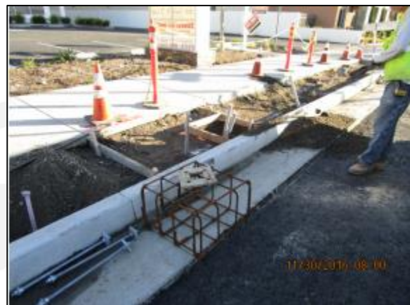
Preparing foundation for F1 pole.
